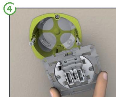
Pour utiliser la fixation par vis, enlever les griffes. Dévisser légèrement les 2 vis de la boîte d'encastrement pour permettre le passage des 2 têtes de vis
