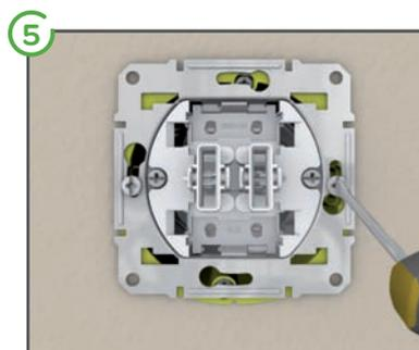
Mettre à niveau l'appareil et le fixer dans la boîte d'encastrement
